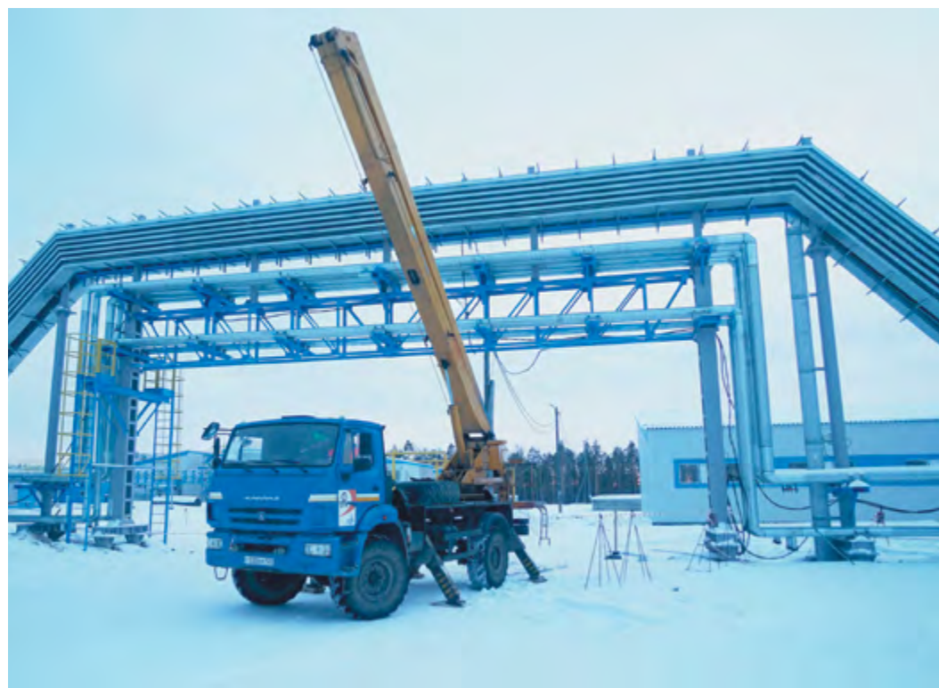
Общая строительная готовность базы составляет более 80%
